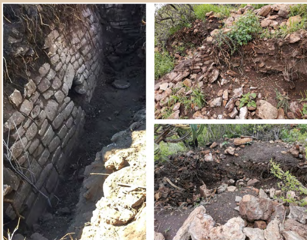
FIGURA 4. Antes y después
